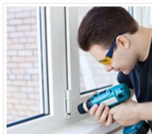
Установка пластиковых окон
