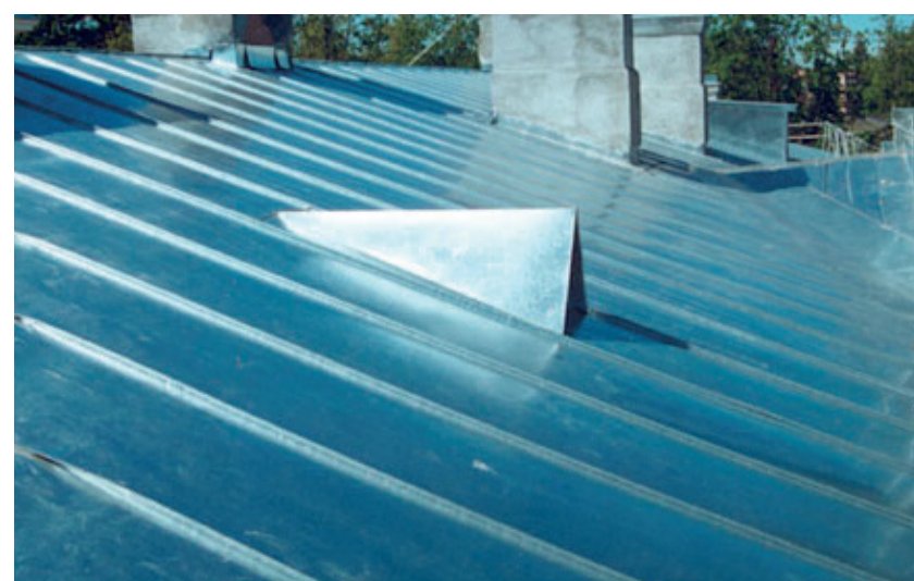
Фасадные кровельные работы
