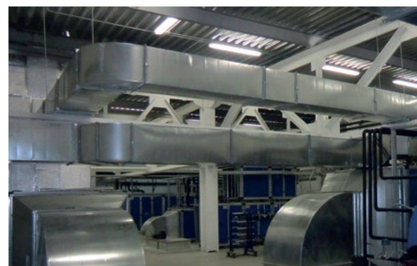
Монтаж системы вентиляции
